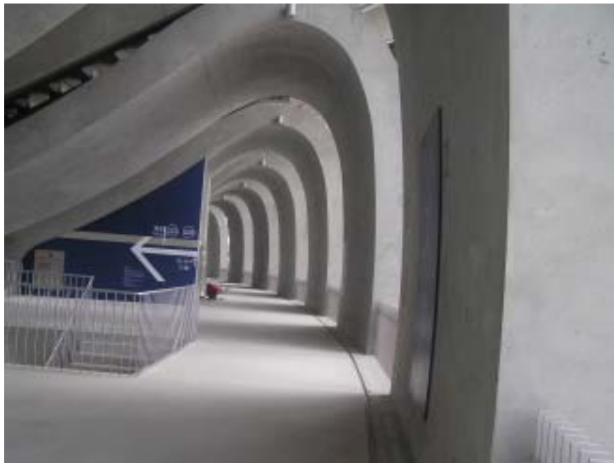
圖 4-3：主場館馬鞍結構（相片來源：研究者）。
