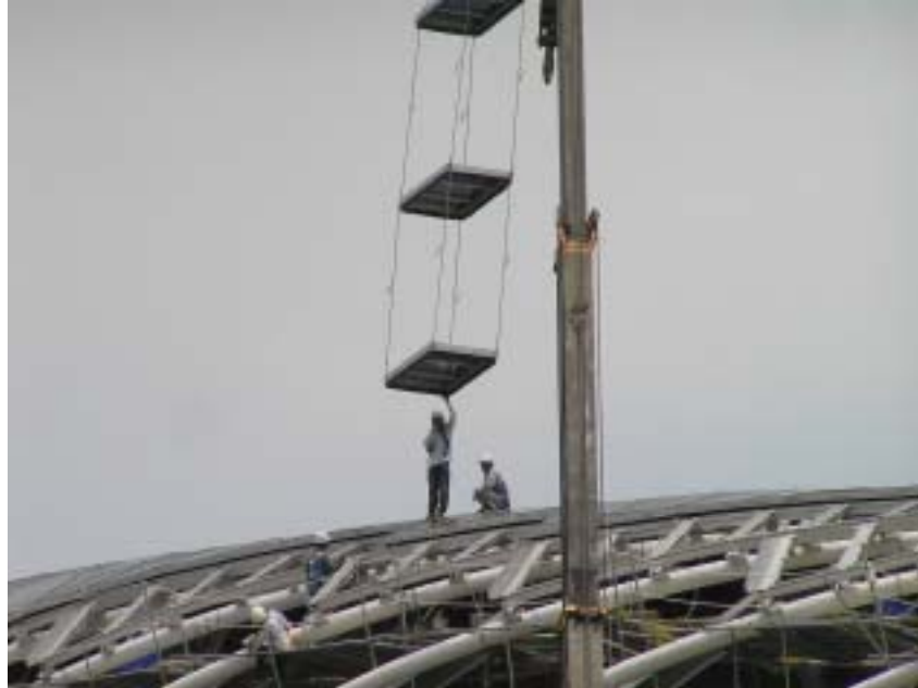
圖 1：太陽能板裝設工程（相片來源：研究者）
