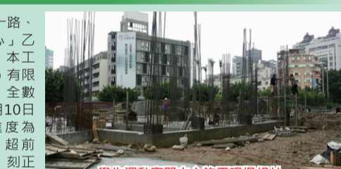
學生運動實習中心施工現場照片
