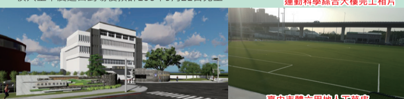
臺中市體六代管場地人工草皮足球場完工
