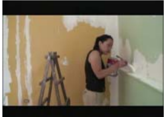
圖 4- 17 重新粉刷房間
