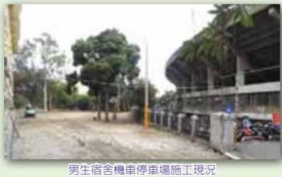
男生宿舍機車停車場施工現況
