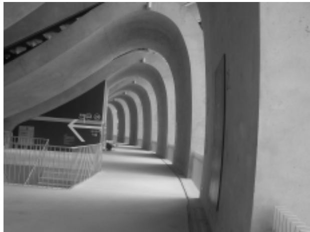
圖 3 主場館馬鞍結構
