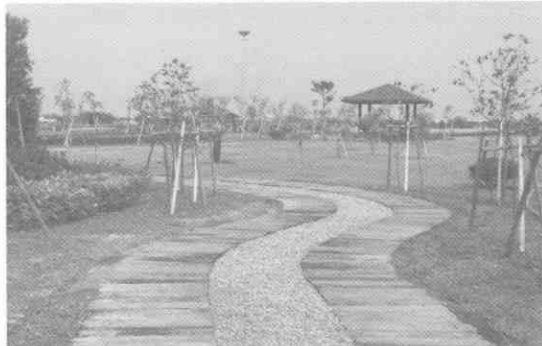
95年度補助彰化縣北斗鎮木球場完工後照片
