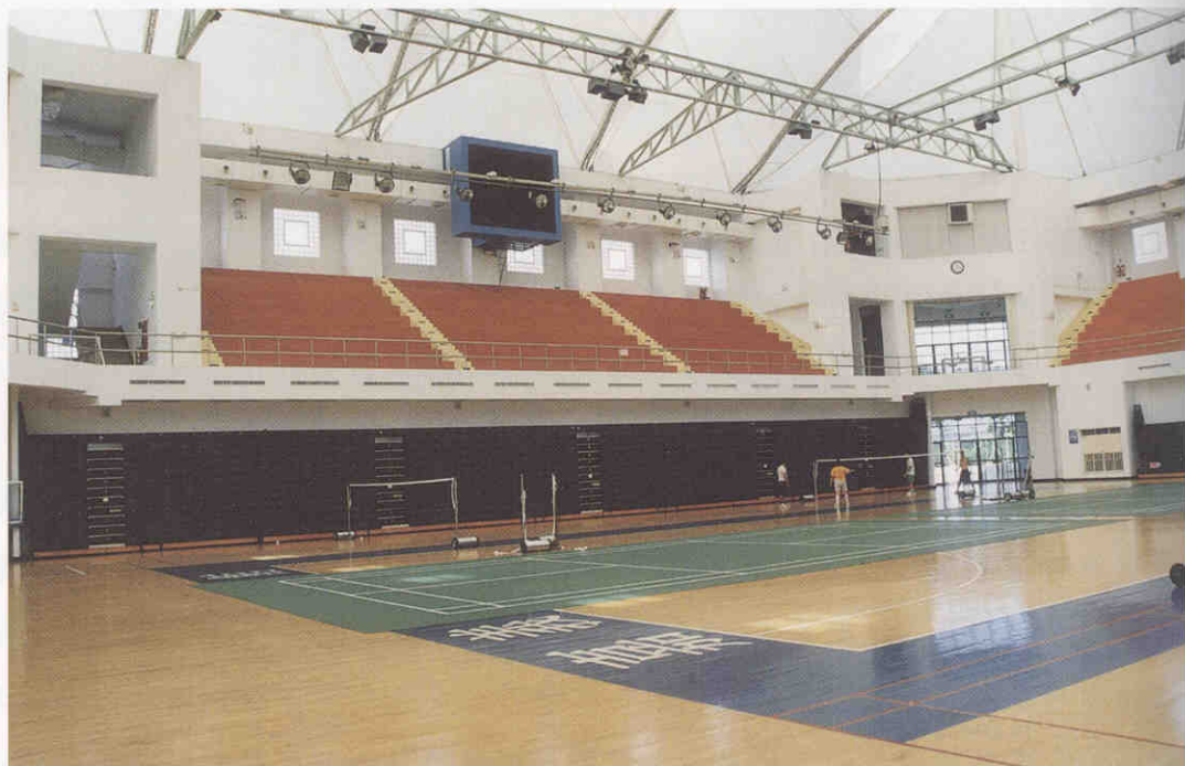
▲體育館採用透光薄膜屋頂設計，日間採光佳，可以節省照明費用支出。（本圖為嘉義縣立體育館/王慶堂攝影）
