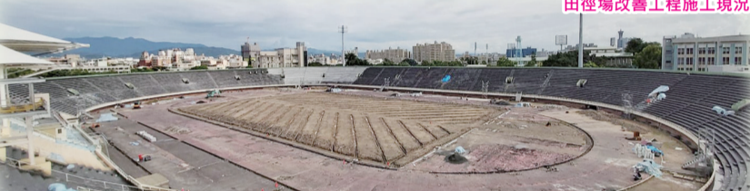
田徑場改善工程施工現況
