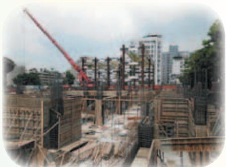
學科大樓地下2樓頂板完成灌漿
