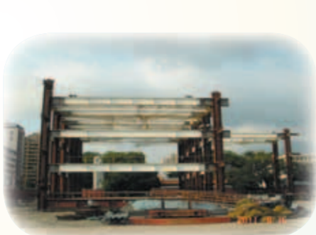
術科大樓第2節鋼構吊裝組立
