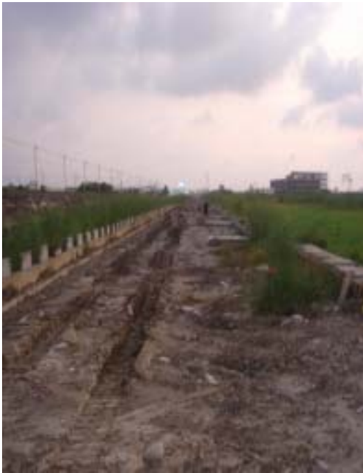
圖 4-14 沿河岸道路拓寬工程
