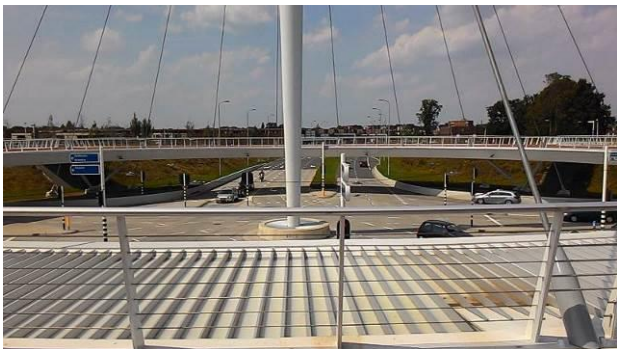
Eindhoven 的自行車空橋：360 度的環型鈎掛式自行車空橋
