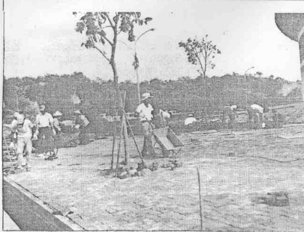
為了搶鋪人行紅磚路，工人日以繼夜加班，晚間還將電燈全開，所有人的辛苦都為了使區運呈現嶄新的風貌。
