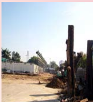
游泳池看臺拆除施工情形
