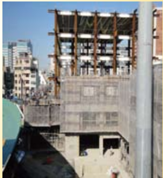
學科大樓三樓頂板組模配筋施工情形
