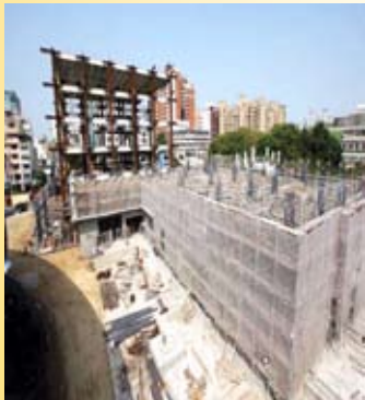
術科大樓三樓鋼筋綁紮施工情形
